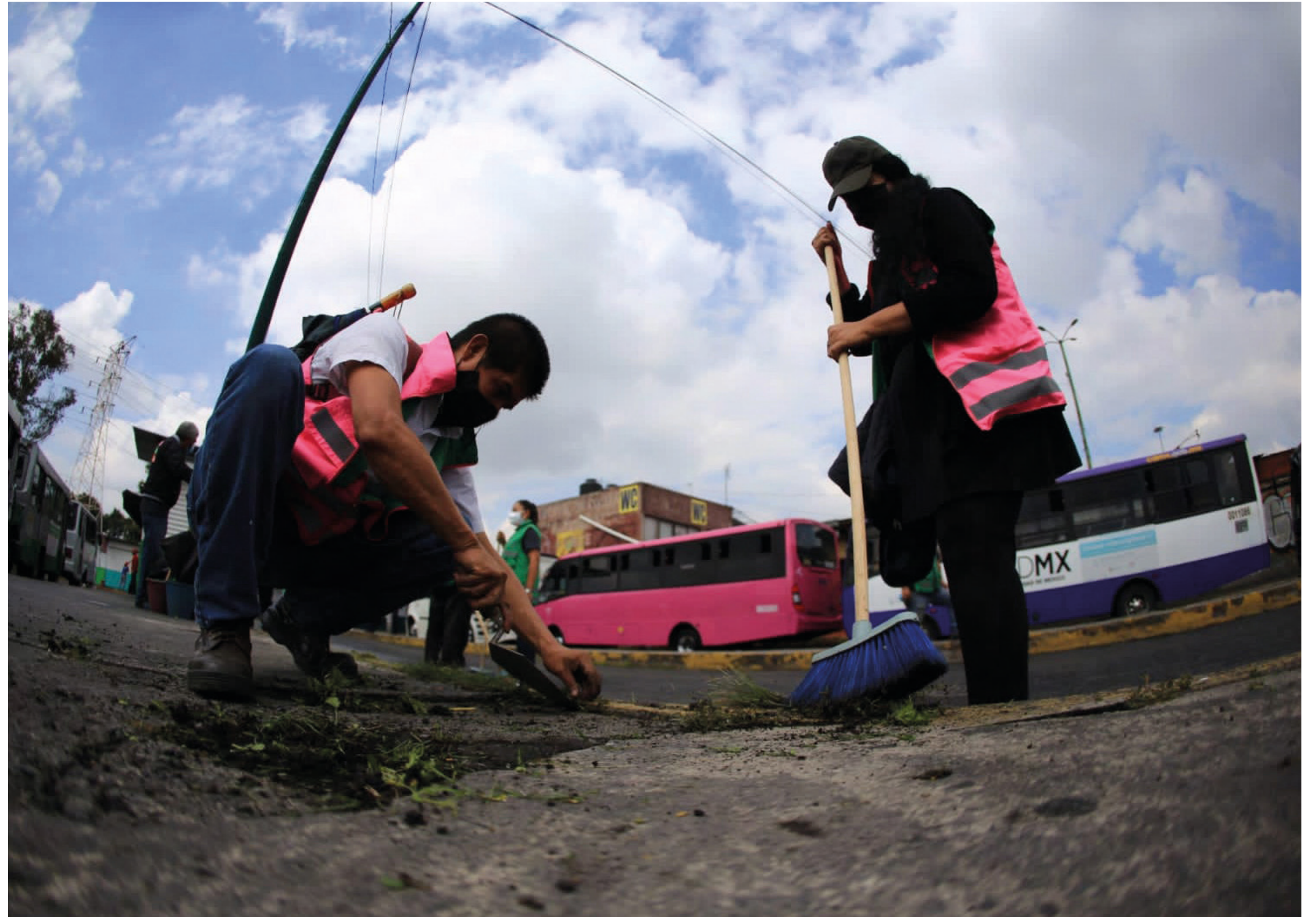
Personal de CETRAM Taxqueña realizando labores de mantenimiento
