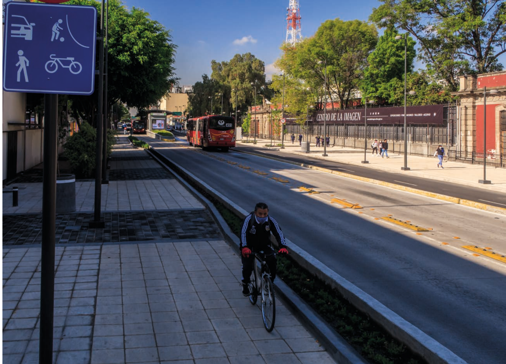
Rehabilitación de la Avenida Balderas
