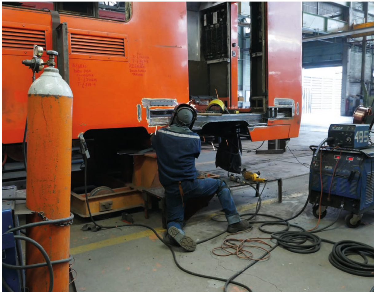
Personal del STC Metro realizando mejoras generales al vagón
