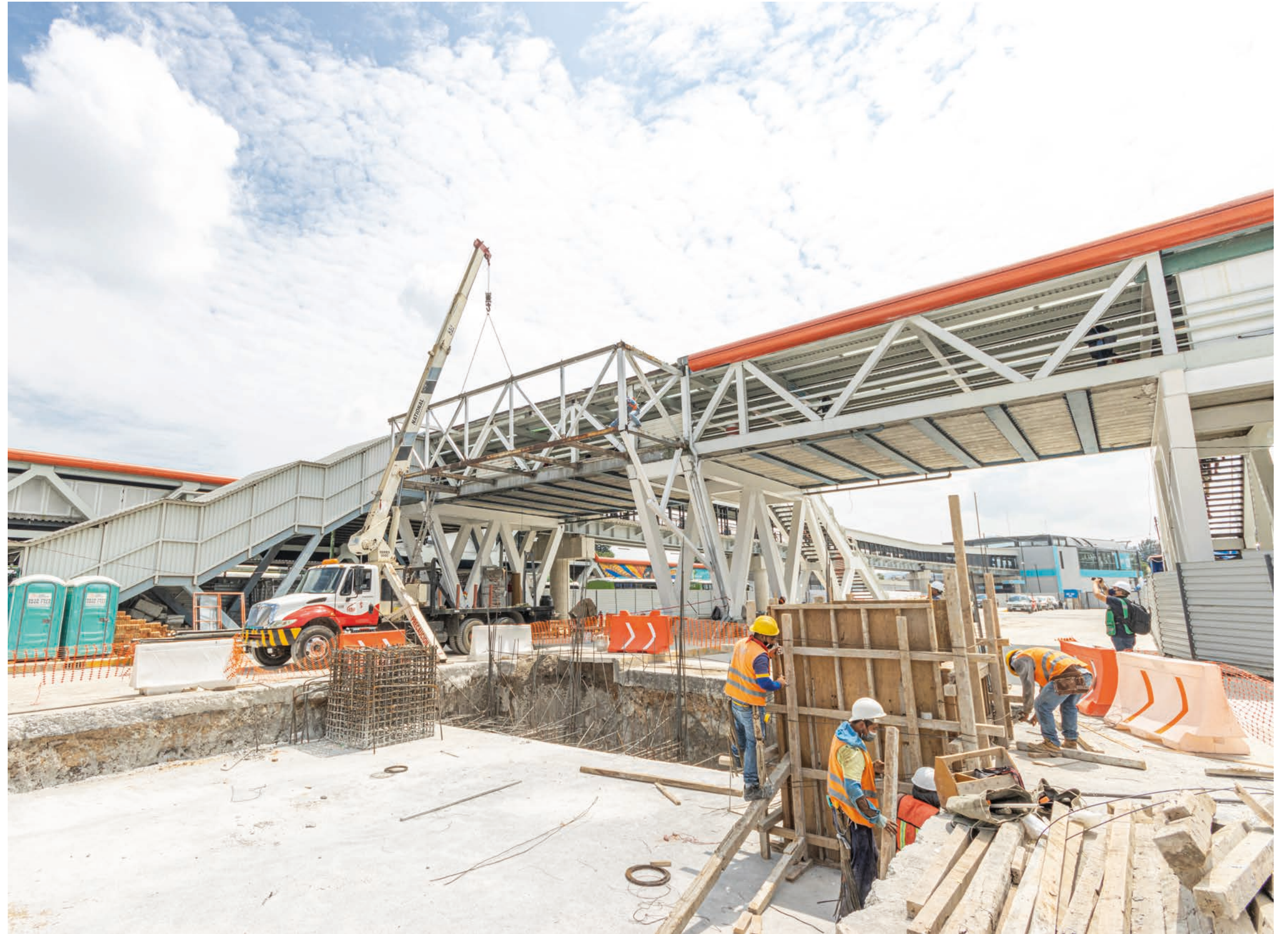
Obras de Trolebús elevado en Constitución de 1917
